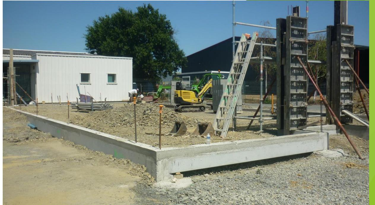
*\* une longrine est une poutre en béton armé qui sert à mieux répartir les charges des éléments supportés.*
