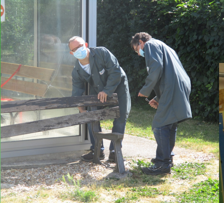
1. Démontér les bancs
